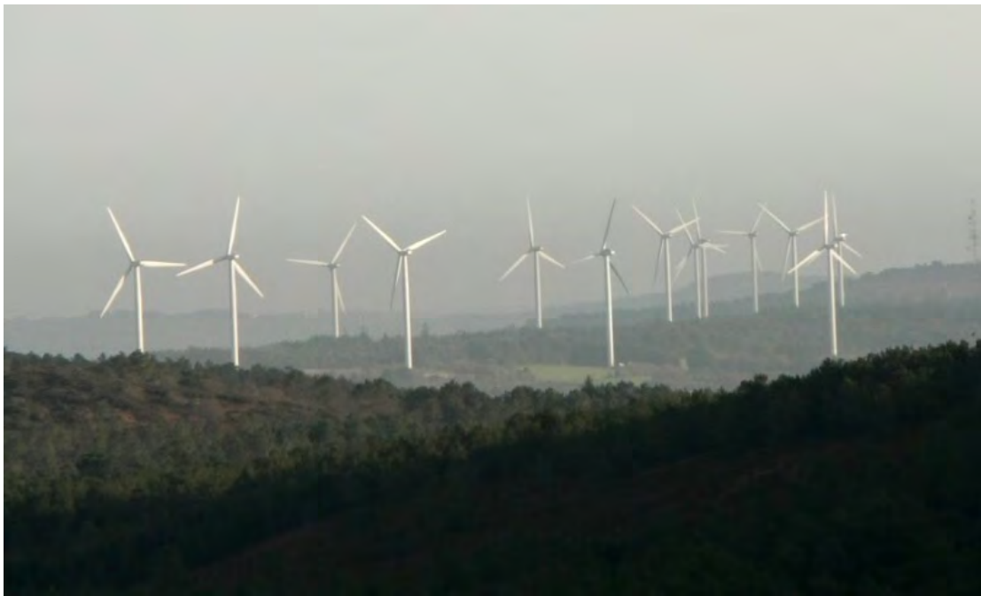
Eoliennes sur le territoire de la CCPCP Source : http://energie-verte.blogspot.com
